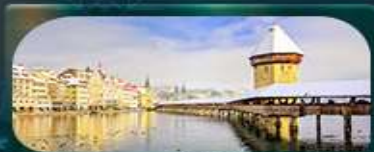
สะพานไมซ์าเปค
